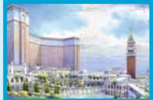
澳门威尼斯人渡假村是亚太地区首个拉斯维加斯式的大型度假村。赌场所有威尼斯式样的外墙设计建造都使用了**AQUAPANEL®**户外水泥板。主板通过封闭式幕墙方式固定于金属框架上。薄砖片贴在水泥板外部。保温隔热层铺设固定在内墙面上，然后固定铁丝网和石膏板。
